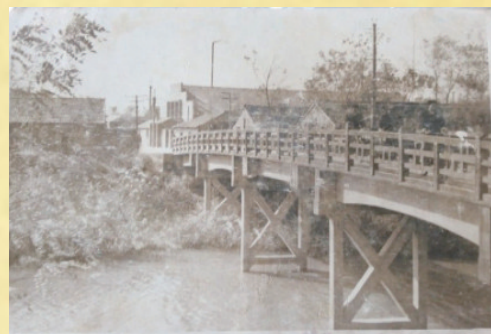
叶邦瑾被绑示众的石桥(后改造成水泥桥)
